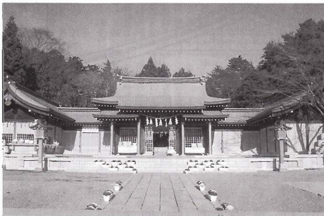
第一期工事完了
